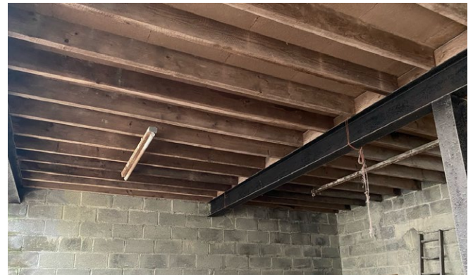
Figure 4: Seilwaith fferm wedi'i adeiladu gan ddefnyddio pren fferm. Lluniau gan Anna Dauksta.
